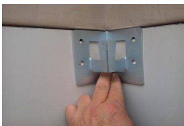
Eckteil montieren
